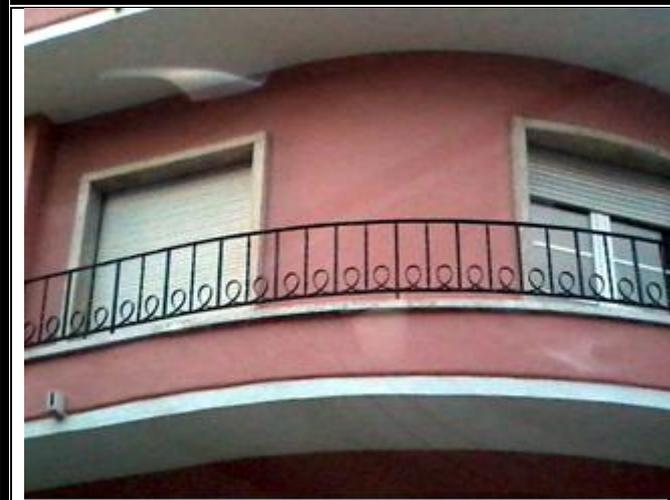
Figura 13 – Varanda excessivamente baixa (zona do murete pode servir de apoio para os pés)
