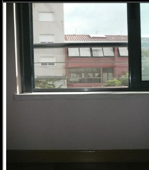
Figura 8 – Janela excessivamente baixa e facilmente transponível (apenas tem dois cabos de aço como barreira entre o parapeito e o elemento superior metálico)
