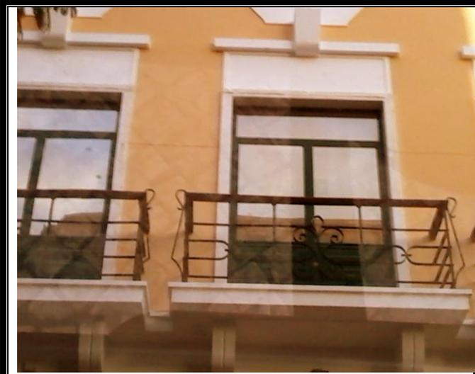
Figura 12 – Gradeamento transponível, (aberturas excessivamente grandes e com zonas que podem servir de apoio para os pés para trepar)
