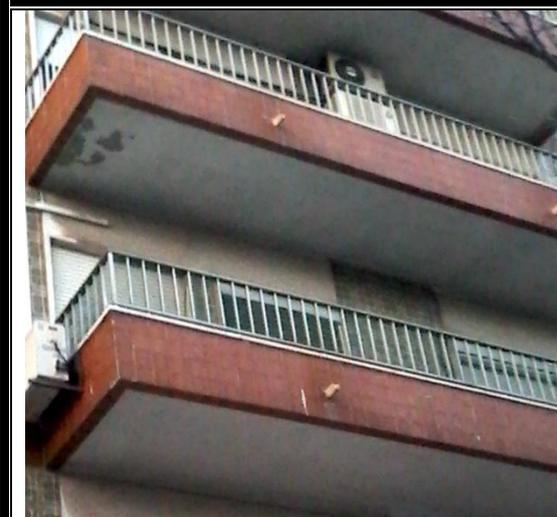
Figura 14 – Varanda excessivamente baixa (zona do murete pode servir de apoio para os pés)
