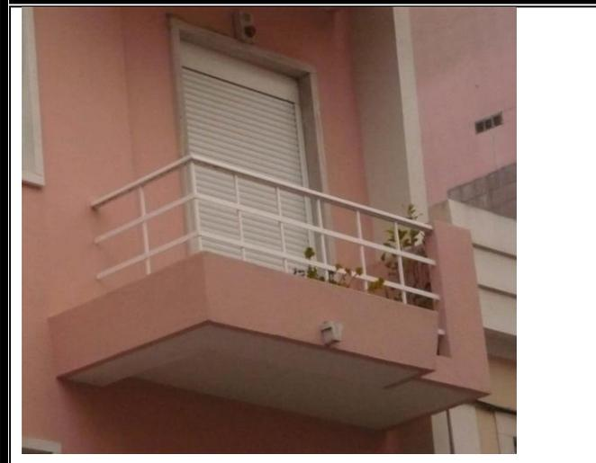
Figura 10 – Gradeamento transponível, aberturas excessivamente grandes (o corpo da criança consegue passar entre o gradeamento)
