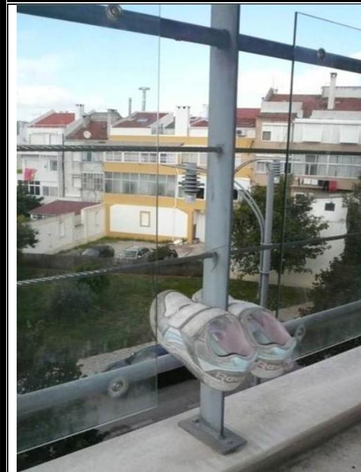
Figura 16 – Guarda com painéis de vidro, mal aplicados (muito afastados), continua a ser possível trepar
