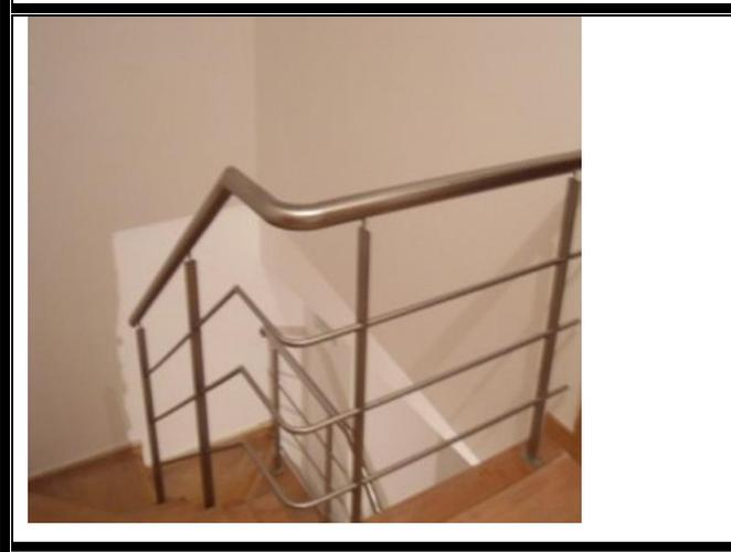
Figura 11 – Gradeamento transponível, aberturas excessivamente grandes (o corpo da criança consegue passar entre o gradeamento)
