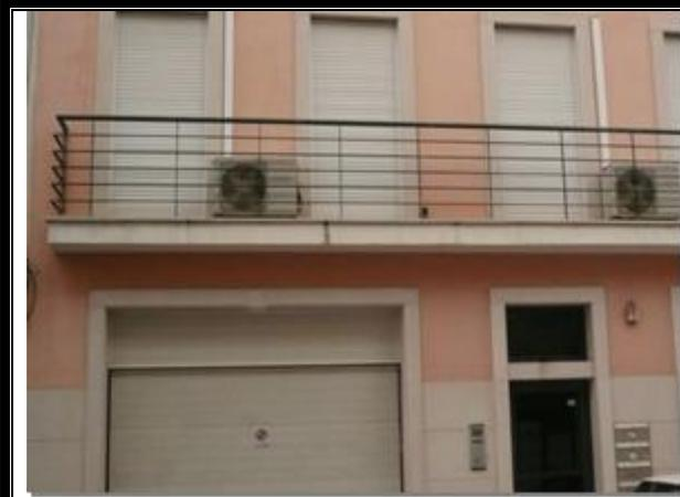
Figura 6 - Gradeamento trepável, tipo “escadas” e ar condicionado serve de apoio para pés
