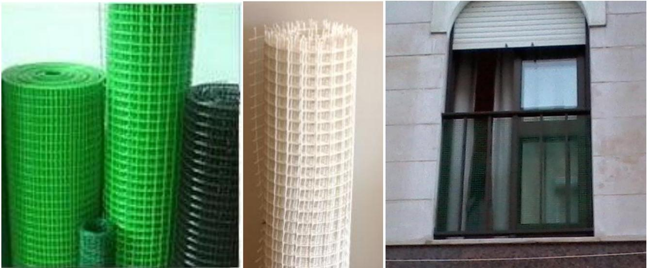
Figura 23 e 24 – Redes rígidas em PVC e Varanda que anteriormente era insegura, devido a abertura excessiva da guarda, protegida com rede rígida em PVC instalada por dentro da guarda original.
