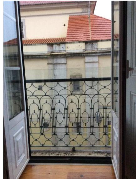
Figura 19 e 20 – Varandas que anteriormente eram inseguras (devido à guarda ser escalável) protegidas com painel em vidro instalado por dentro da guarda original.
