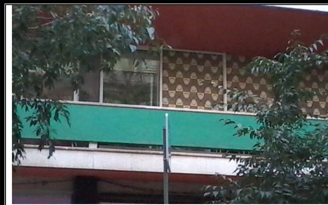
Figura 15 – Espaçamento entre a base da guarda e o chão é excessivamente grande (perigo do corpo da criança passar e a cabeça não, ficando suspensa pelo pescoço)
